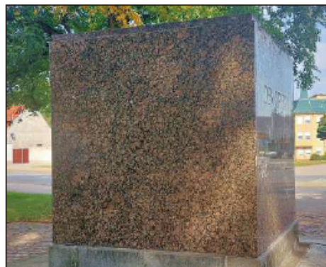
Diese Fläche mit Blickrichtung Hecklinger Straße ist bisher frei. Hier soll eine neue Inschrift eingesetzt werden.
